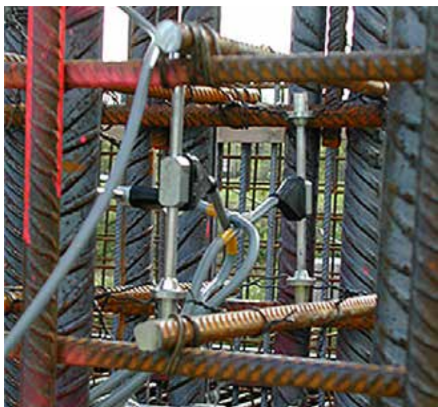
Pose d'extensomètres à corde vibrante pour une alvéole de stockage du centre de stockage de l'Aube pour les mesures de déformation.
