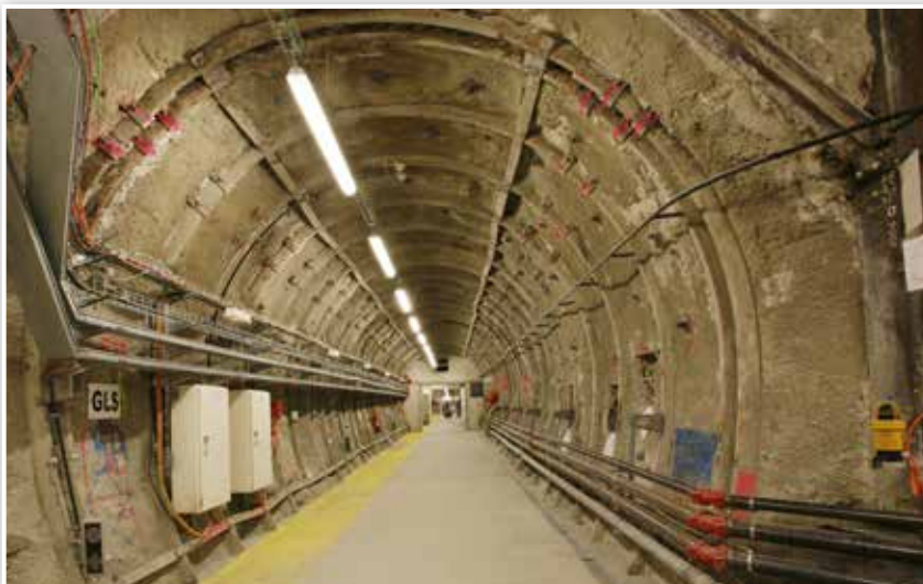
► Galerie du Laboratoire souterrain
